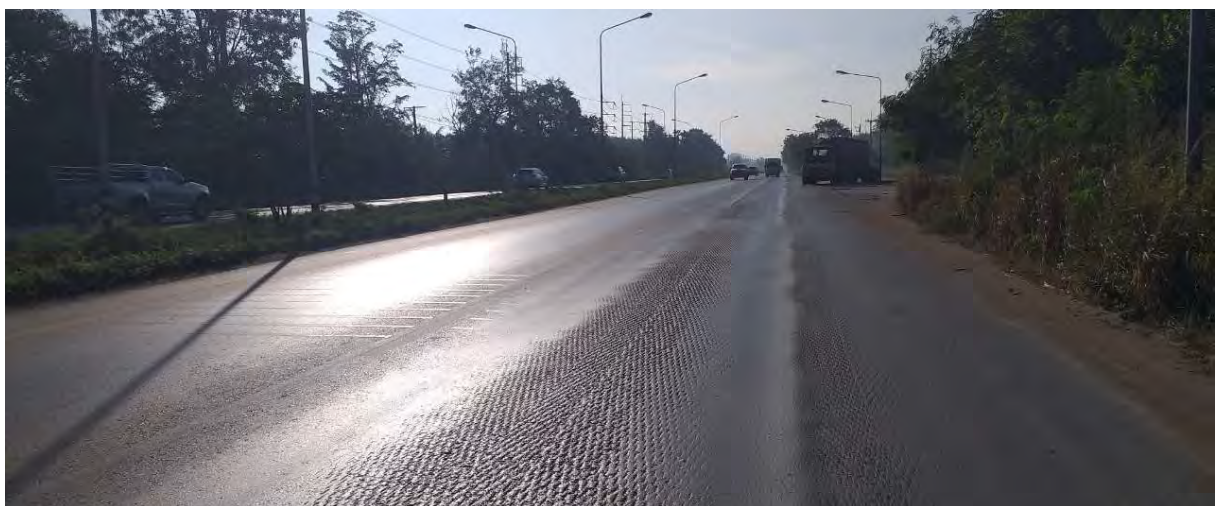
ภาพที่ ๔.๑ ร่องล้อที่เกิดขึ้นทางหลวงหมายเลข ๓๔๔ ด้านซ้ายทาง (ธันวาคม ๒๕๖๖)
