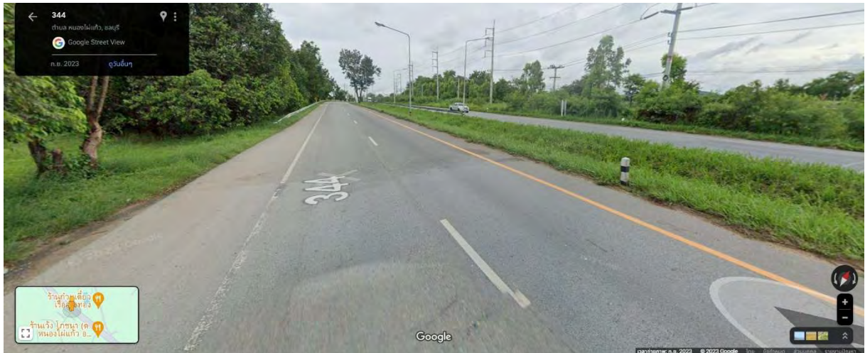
ภาพที่ 3.4e รูปภาพหลังการบูรณะทางหลวงหมายเลข 344 ตอน อ.บ้านบึง – อ.แกลง (RT) ที่ใช้ผิวทาง Porous Asphalt Concrete (ภาพจาก Google Streetview)
