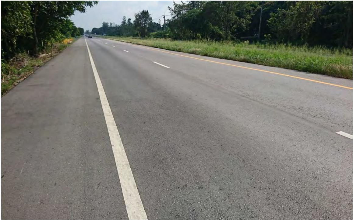
ภาพที่ 3.4b รูปภายหลังจากบูรณะทางหลวงหมายเลข 344 ตอน อ.บ้านบึง – อ.แกลง กม. 55+ 000 LT
