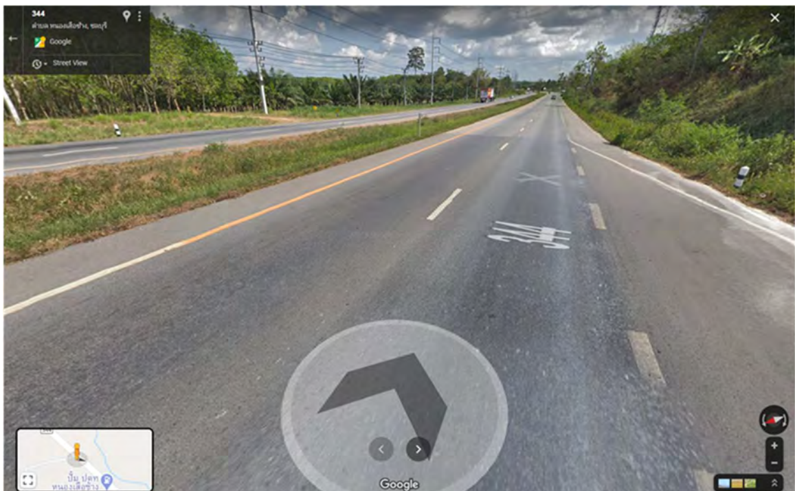
ภาพที่ 3.4d รูปภายหลังการบูรณะทางหลวงหมายเลข 344 ตอน อ.บ้านบึง – อ.แกลง (RT) บริเวณ จุดแบ่งพื้นที่ก่อสร้าง ตอน 1-1 และ ตอน 1-2 (ภาพจาก Google Streetview, 2562)
